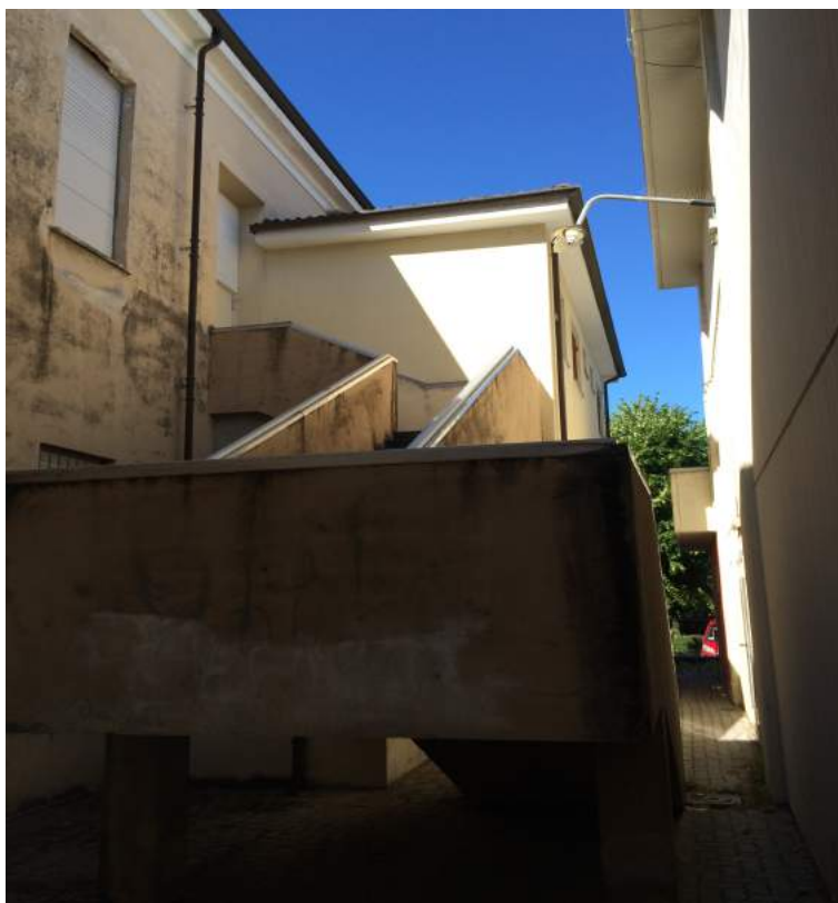
Foto 16 – Prospetto Nord: scala antincendio
