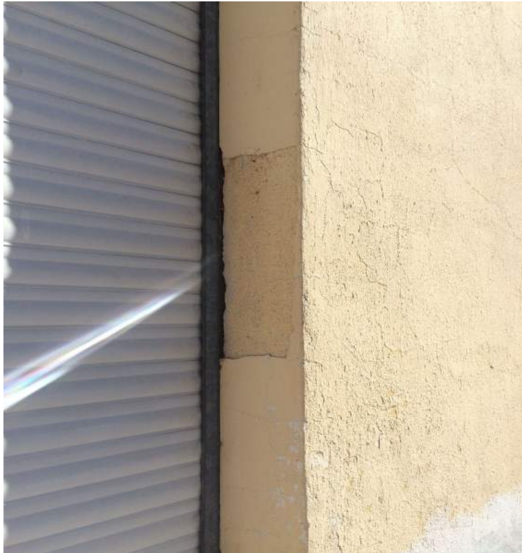
Foto 4 – Prospetto Sud: particolare distacco
