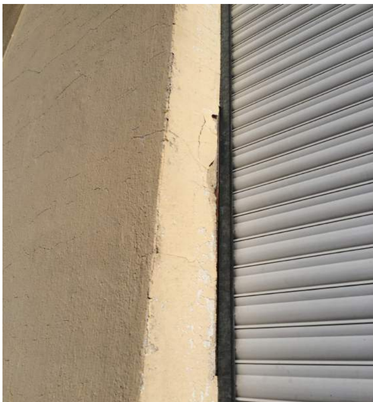
Foto 5 – Prospetto Sud: particolare distacco
