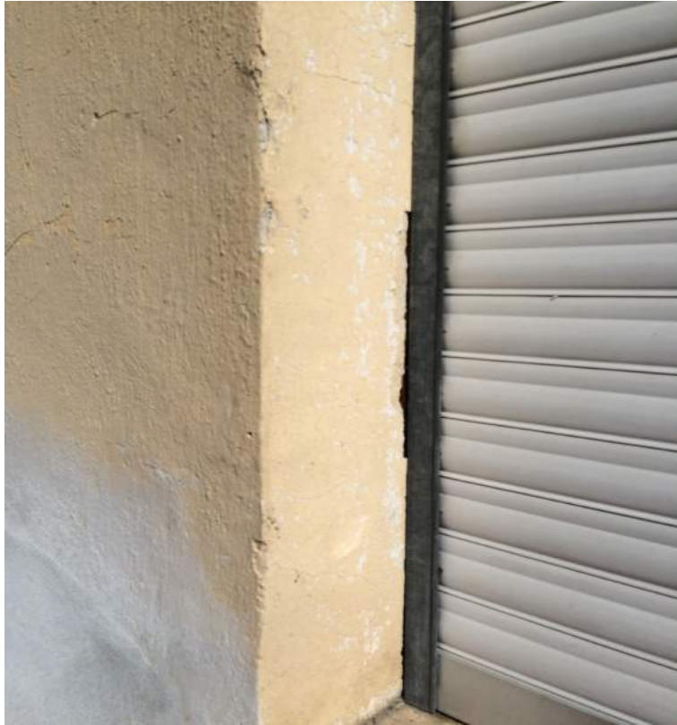
Foto 3 – Prospetto Sud: particolare tinta friabile
