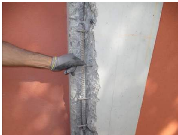
Foto 3 – Prelievo barra di armatura.
