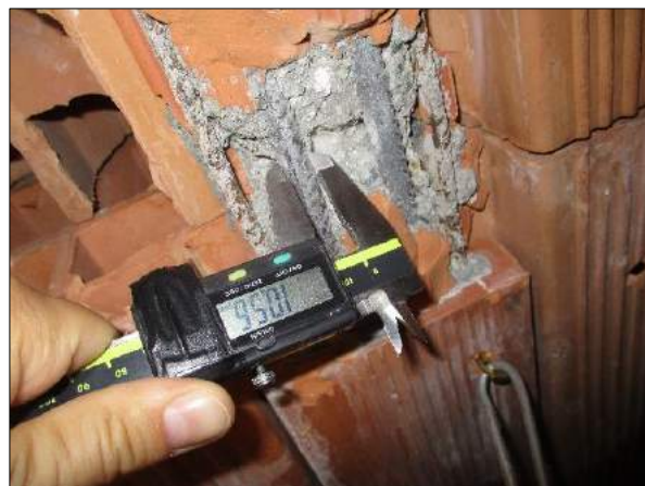
Foto 8 – Rilievo del solaio condotto mediante demolizione localizzata dell'intradosso.
