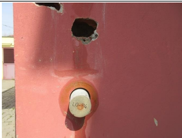
Pacometria e prelievo campione calcestruzzo eseguite sul pilastro 41 al piano terra.
