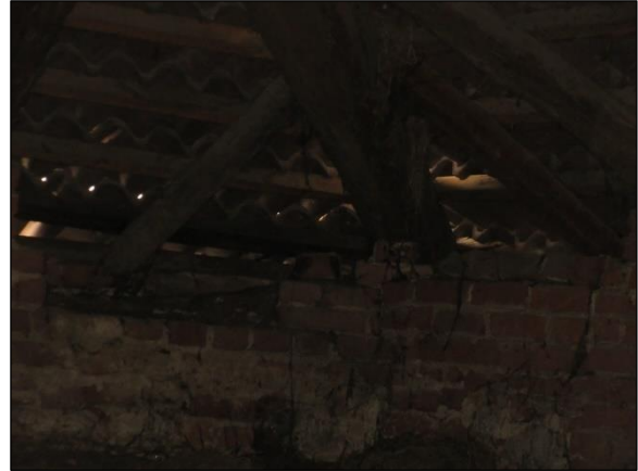
Foto n°7 - Individuazione di trave d'angolo spingente con rischio di ribaltamento del cantonale.
