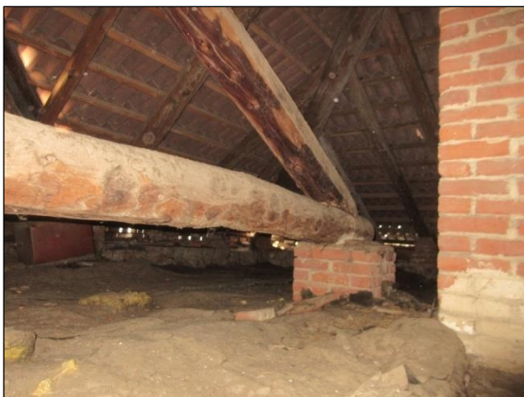
Foto n°8 - Appoggio della capriata privo di qualsiasi dispositivo di contenimento.
