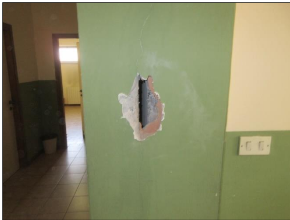
Foto n°4 - Individuazione giunto strutturale non sismicamente efficace tra US3 e US4.
