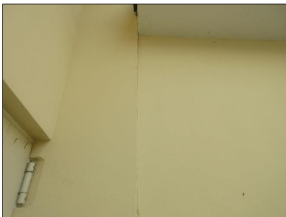
Foto n°2 - Individuazione giunto strutturale non sismicamente efficace tra US1 e US5.
