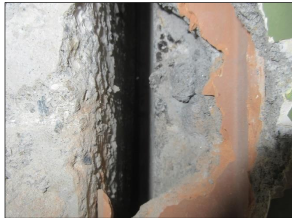
Foto n°5 - Particolare giunto strutturale non sismicamente efficace tra US3 e US4.
