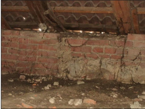
Foto n°6 - Dettaglio dell'assenza di un cordolo di contenimento delle spinte della copertura.
