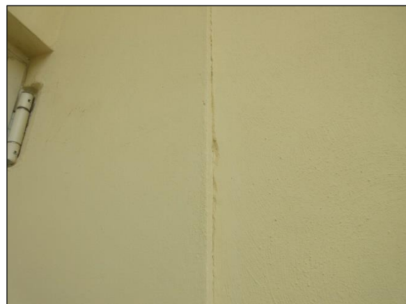
Foto n°3 - Particolare giunto strutturale non sismicamente efficace tra US1 e US5.
