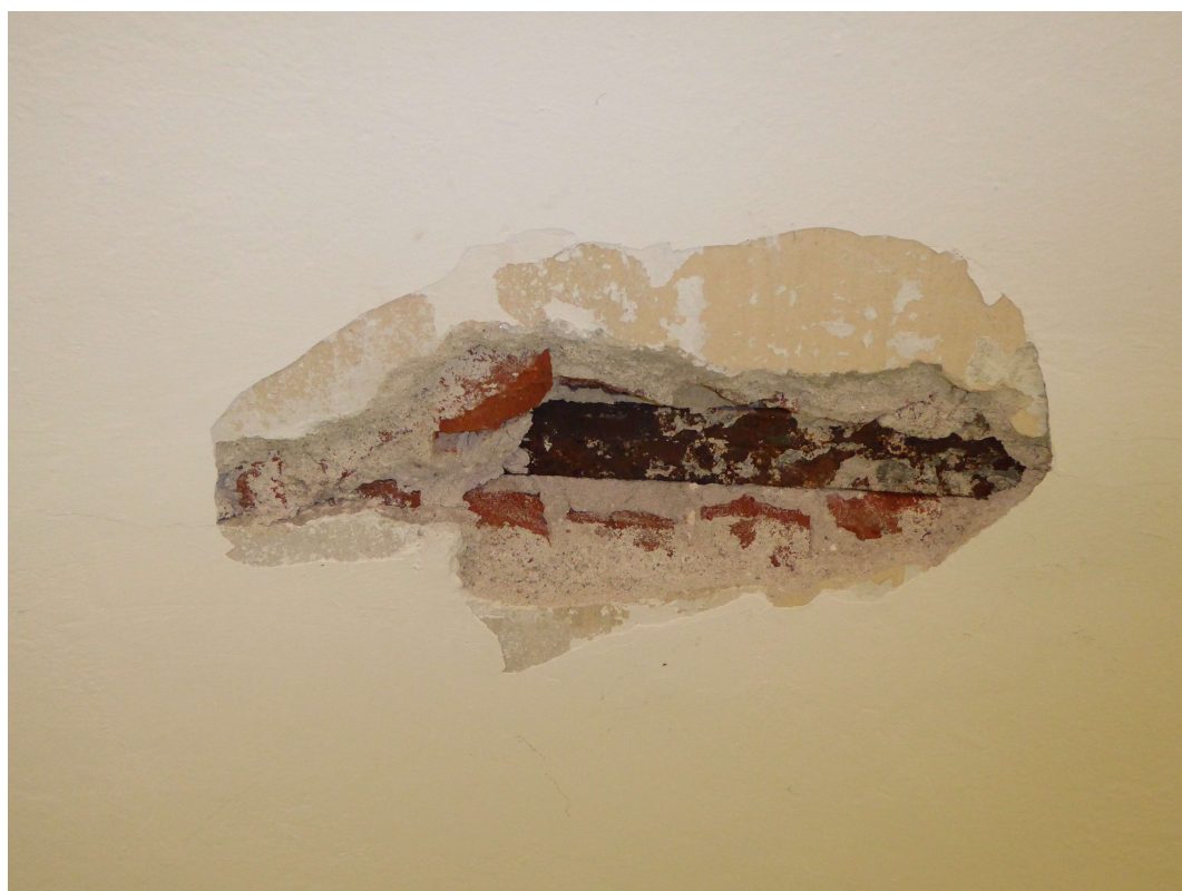
FOTO 10 – [INTERNO] Dettaglio del distacco. Visibile la putrella sottostante.
