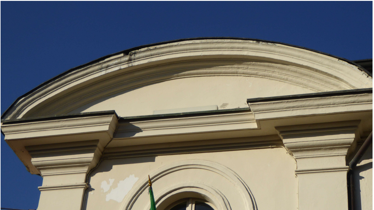
FOTO 5 – Erosione di elementi decorativi, cornicioni e timpani
