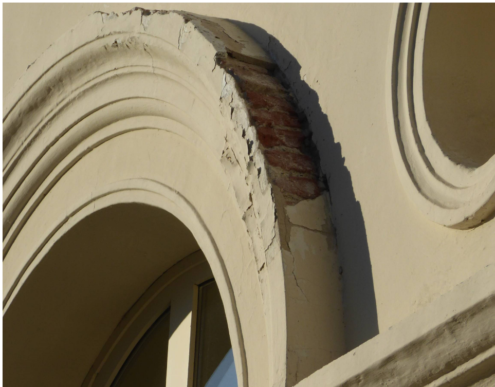
FOTO 7 – Lacune puntuali che comportano la caduta di intere porzioni di intonaco e il suo distacco nelle aree circostanti
