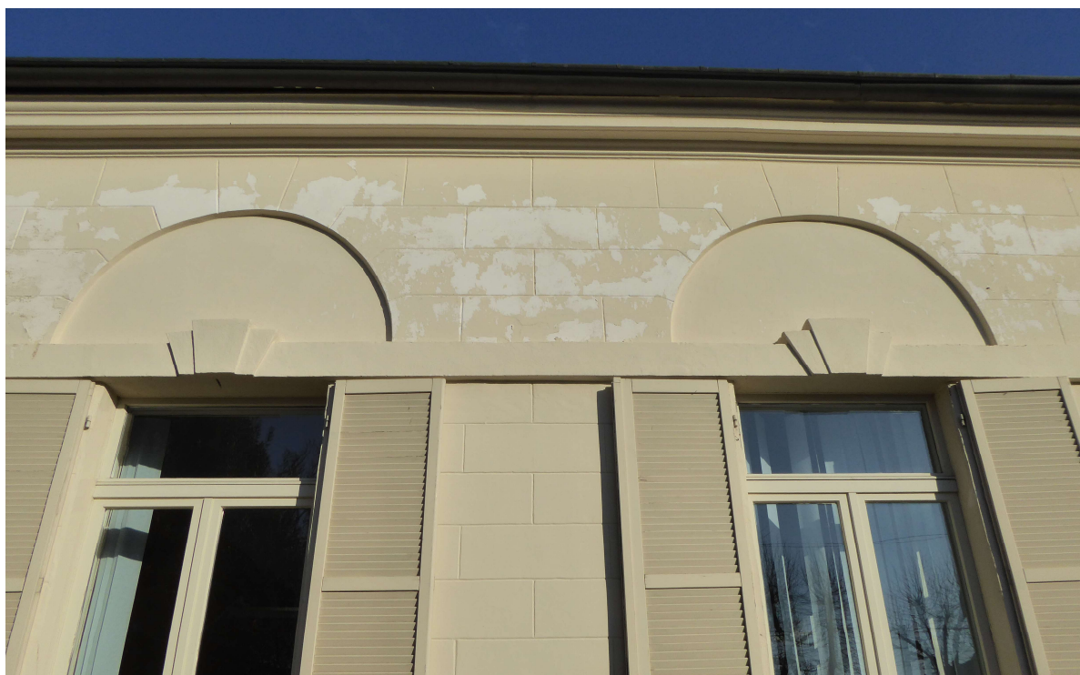
FOTO 8 – Esfoliazione dello strato superficiale diffusa su tutte le porzioni di facciata maggiormente esposte al sole e ad agenti atmosferici.
