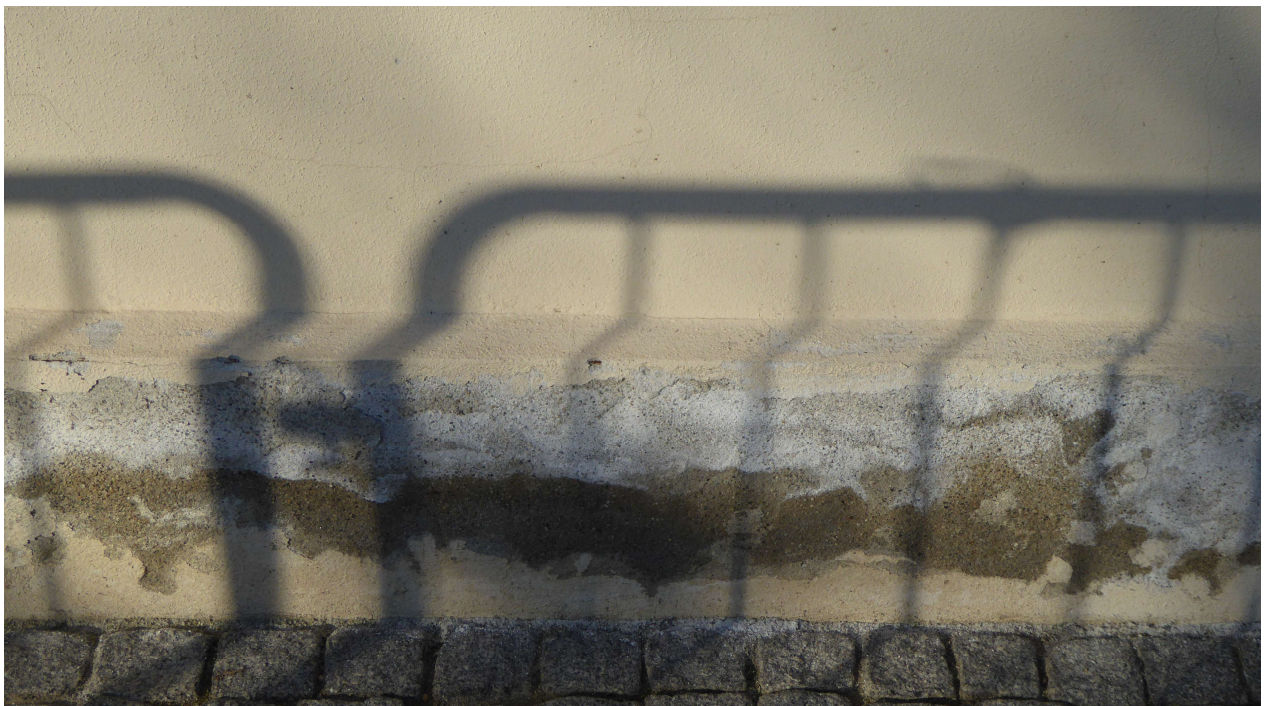
FOTO 6 – Ammaloramento generale che interessa l'intera fascia basamentale, comprensivo delle seguenti patologie: macchia; disgregazione; distacco puntuale; esfoliazione puntuale; colonizzazione biologica puntuale.
