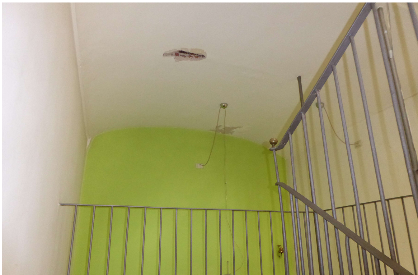
FOTO 9 – [INTERNO] Distacco di porzione di intonaco sul soffitto del vano scala
