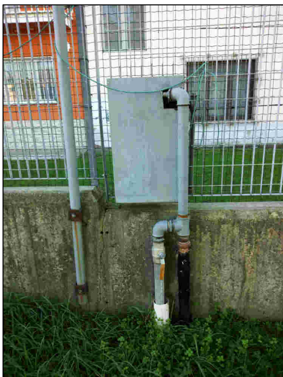
Foto 4_ Contenitore del contatore del gas Metano della centrale termica
