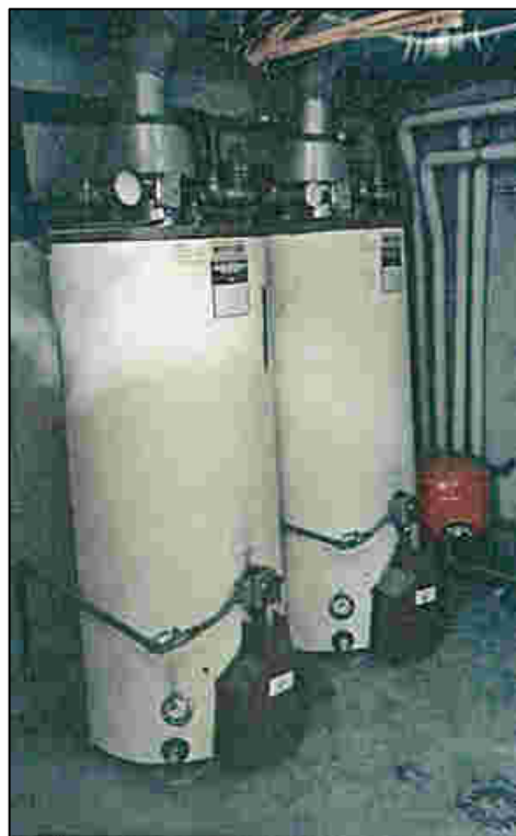
Foto 3_ Bollitori a gas Metano per la produzione di acqua calda sanitaria
