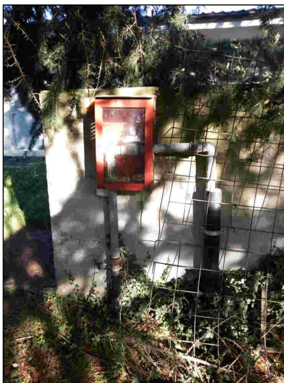
Foto 5_ Valvola di intercettazione combustibile della centrale termica
