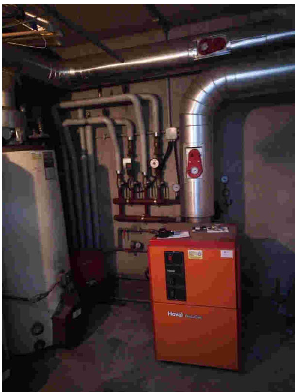
Foto 2_ Distribuzione secondaria esistente dell'impianto di riscaldamento
