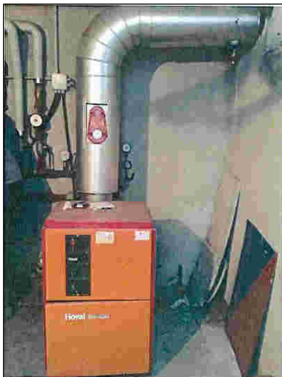
Foto 1_ Generatore di calore esistente
